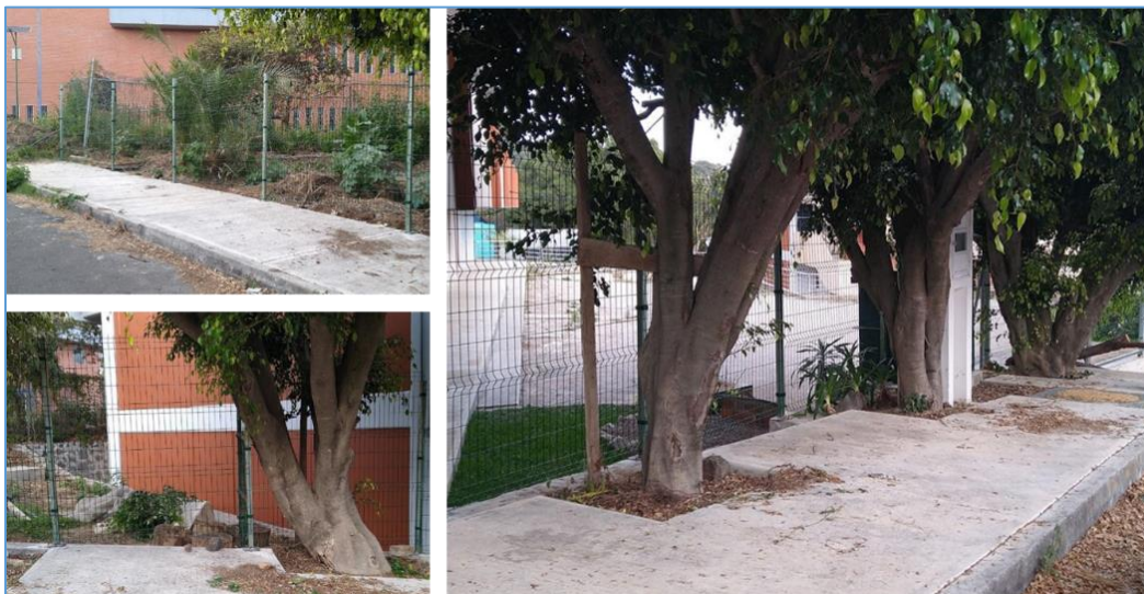
Figura 36. Colocación de la reja tipo Lemus perimetral.
