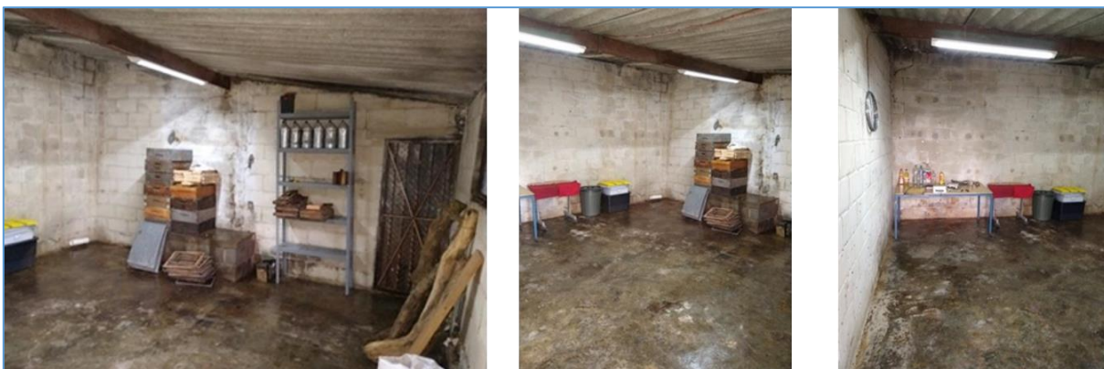
Figura 40. Rehabilitación de la bodega para la producción de miel.
